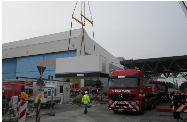
Absetzen der oberirdischen Kompaktstation mit Autokran
